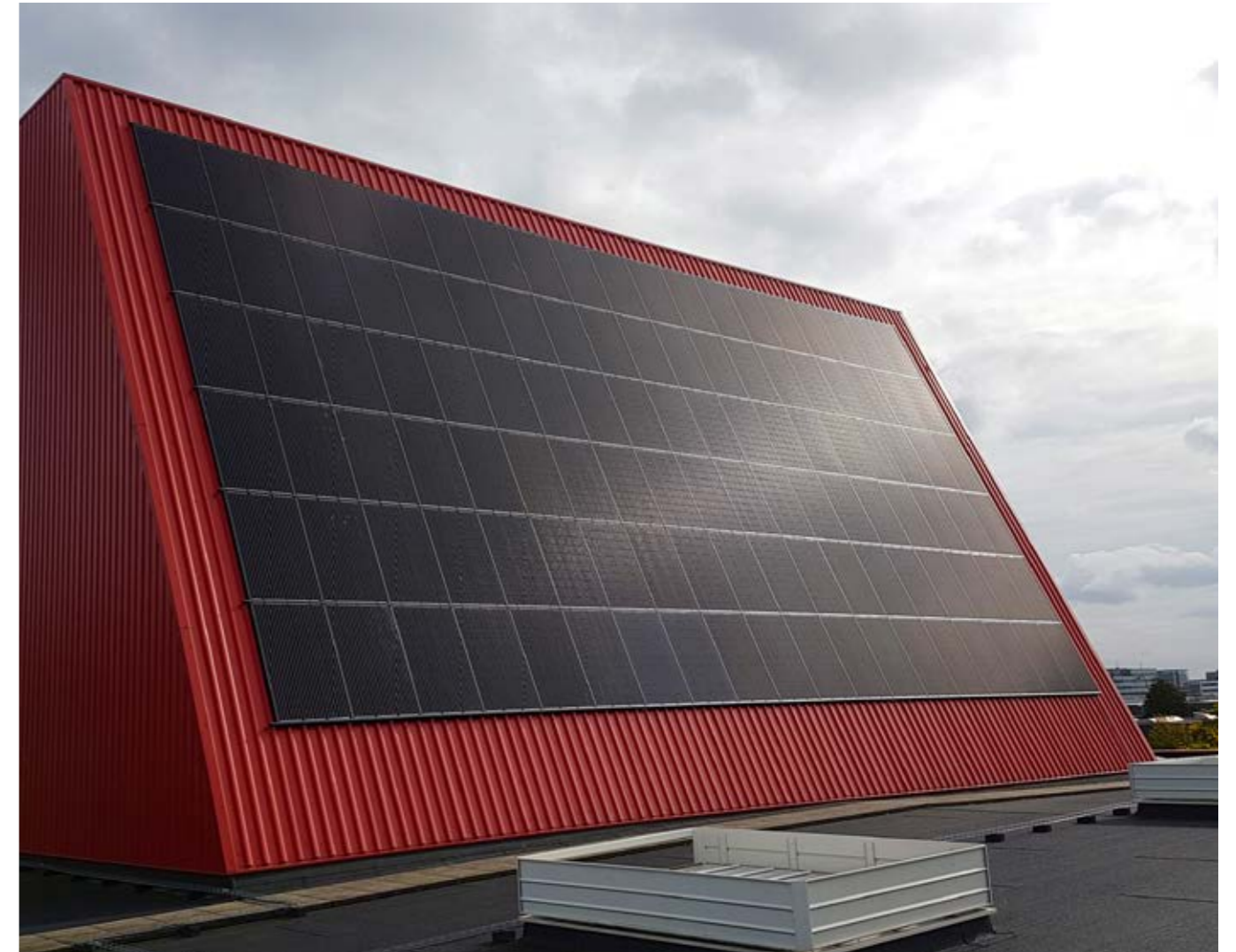
In de zomer van 2017 werden er zonnepanelen op het dak van het Decoratelier geplaatst
